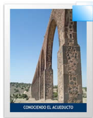
Figura 2.- Acueducto del padre Tembleque. Zempoala, Estado de Hidalgo Fuente: [3]
