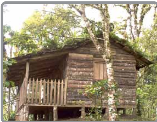
Forma de construcción de vivienda rural, por factor climatológico, Condega, Estelí, Nicaragua.
