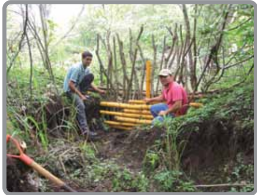
Estudiantes de la Carrera de Ciencias Ambientales de la FAREM - Estelí / UNAN Managua, en aplicación de una técnica de contención para evitar más deslizamiento del suelo.
