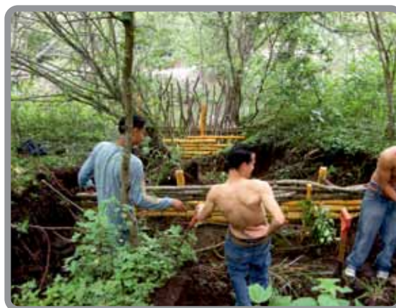
Estudiantes de la FAREM / Estelí - UNAN Managua construyendo barreras de protección para el suelo.
